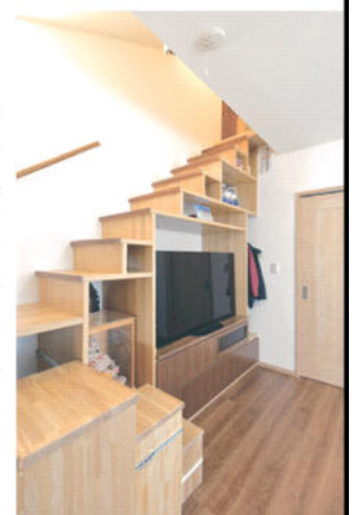
壁面の収納棚の一部を引き出すと、階段となってロフトへ続く
